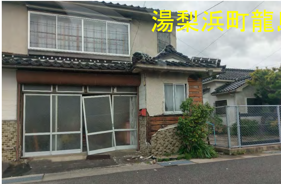
外壁モルタルの脱落(県道22号線沿いの住宅)
