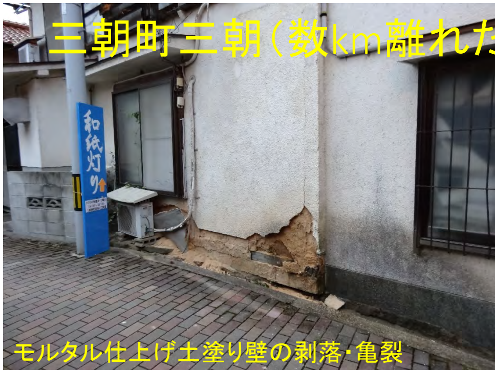
基礎コンクリート仕上げの剥落
