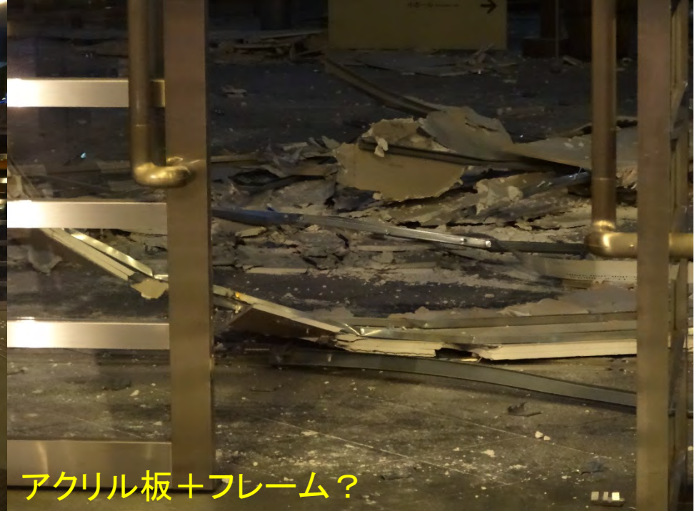
花壇側面の化粧材の被害
