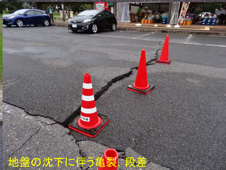
地盤の沈下に伴う亀裂, 段差
