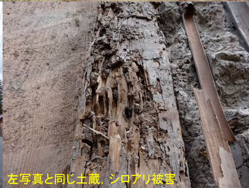
土蔵の大破(老朽化が進んでいる)
