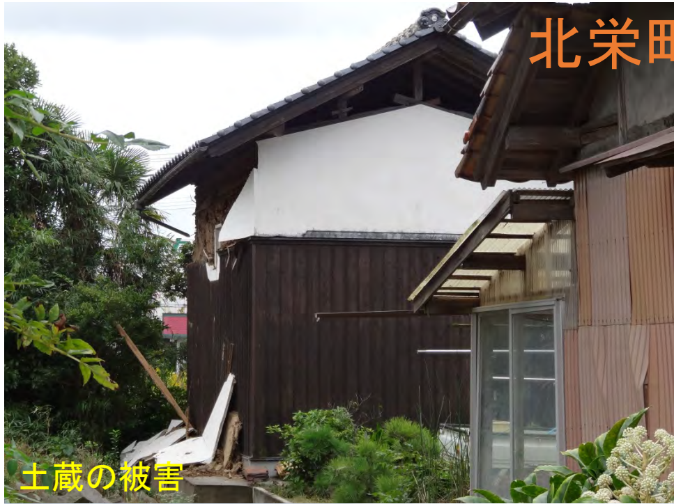
土蔵の被害, 残留傾斜
