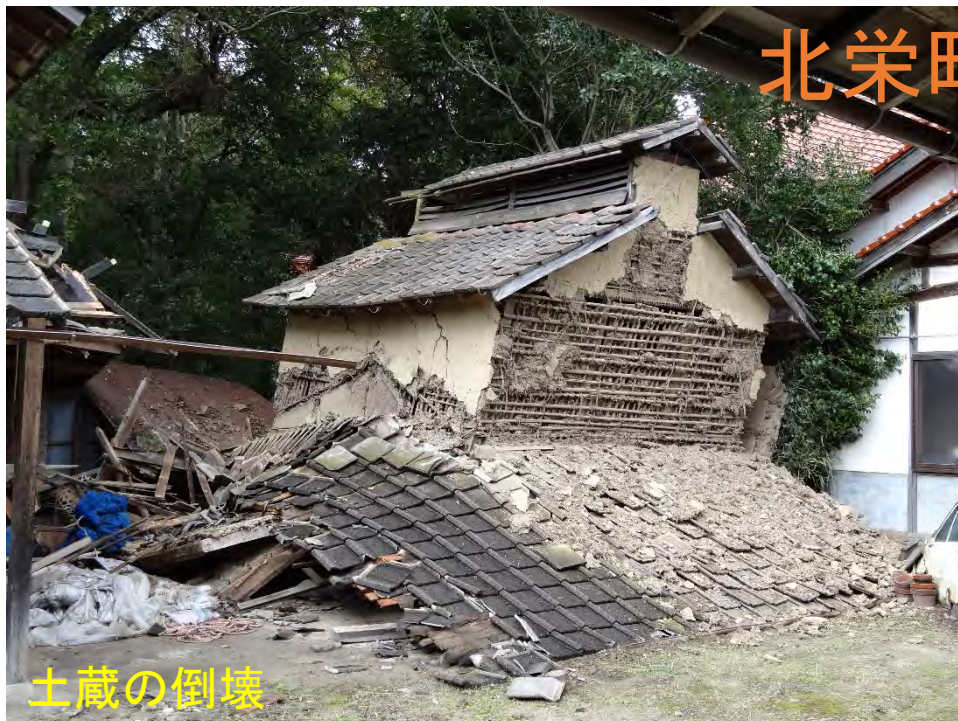
土蔵の大破(老朽化が進んでいる)
