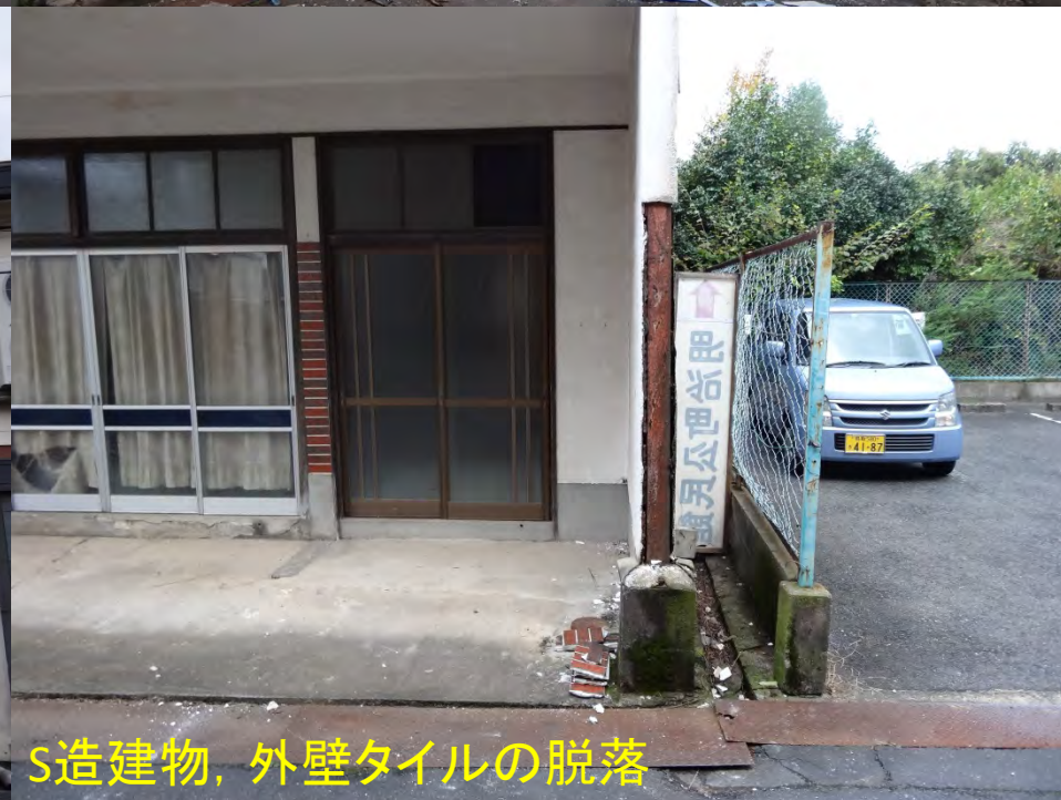
S造建物、外壁の脱落
