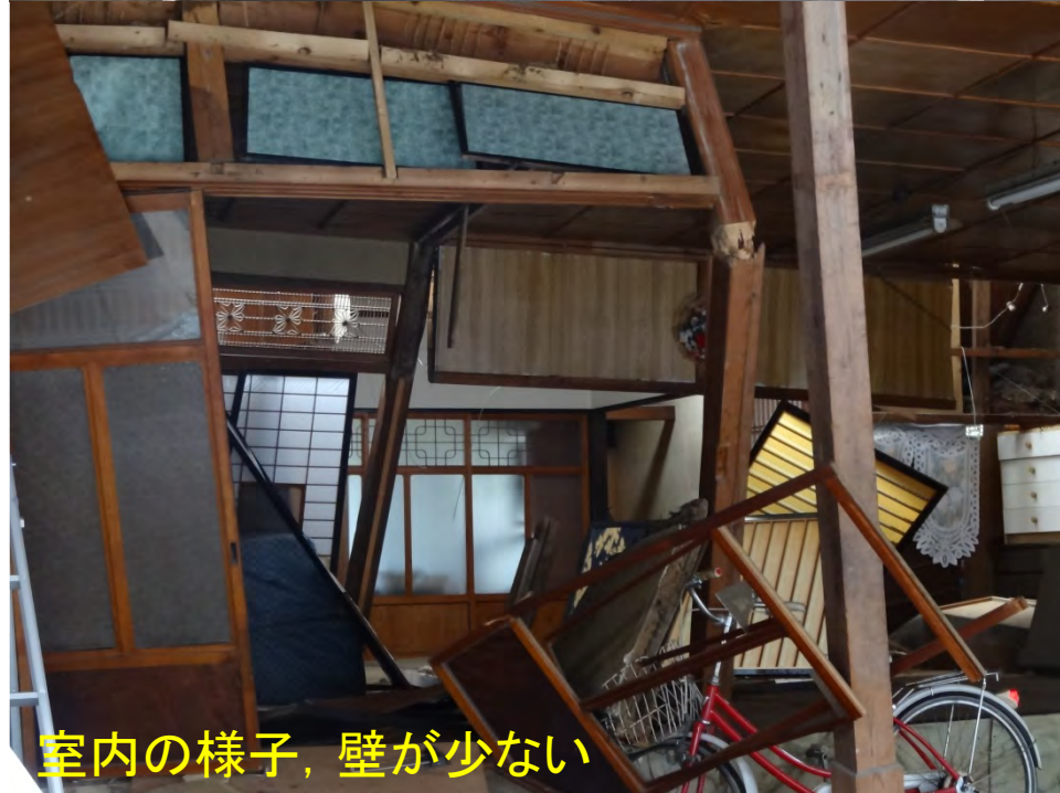
大破した住宅，残留傾斜大
