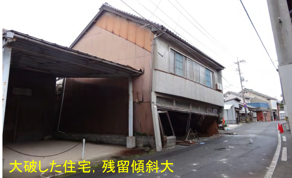
大破した住宅，残留傾斜大
