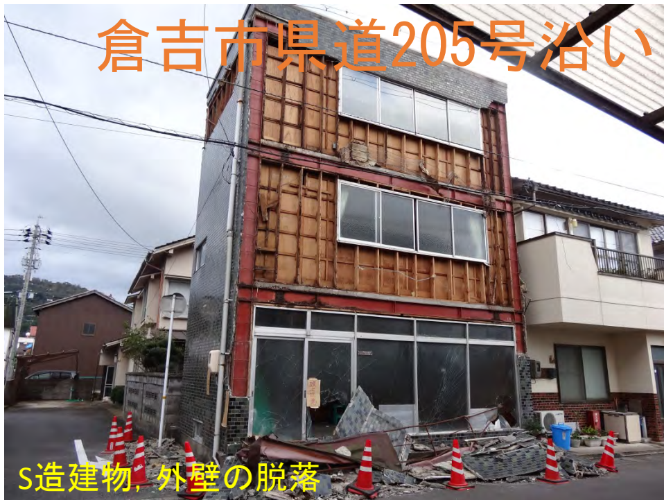
S造建物、外壁の脱落
