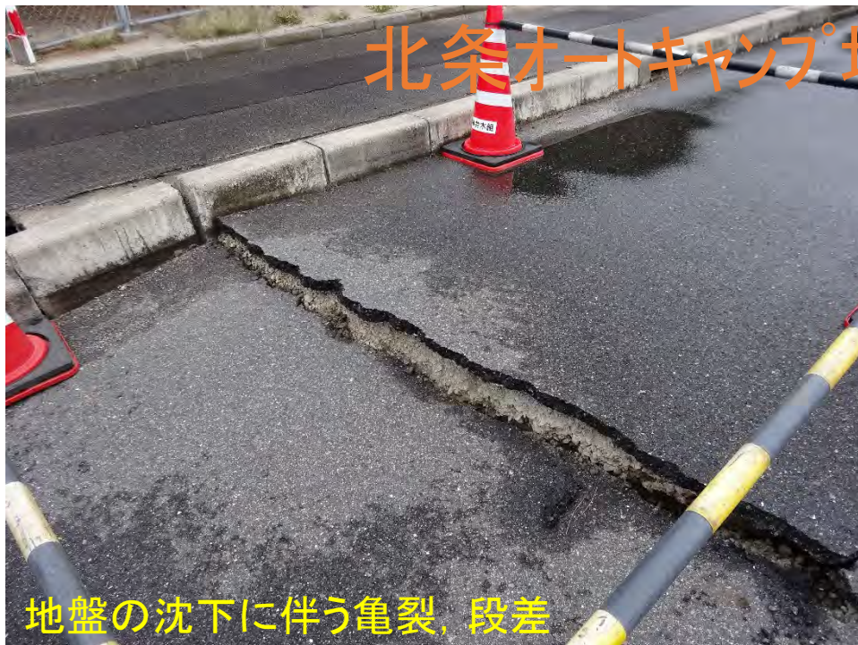
地盤の沈下に伴う亀裂, 段差
