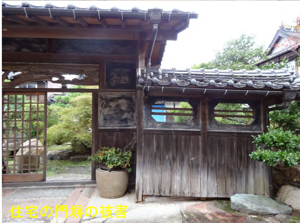
漆喰仕上げの剥落
