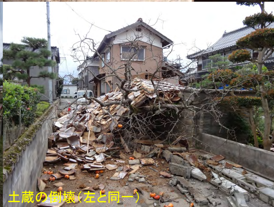
土蔵の倒壊(左と同一)
