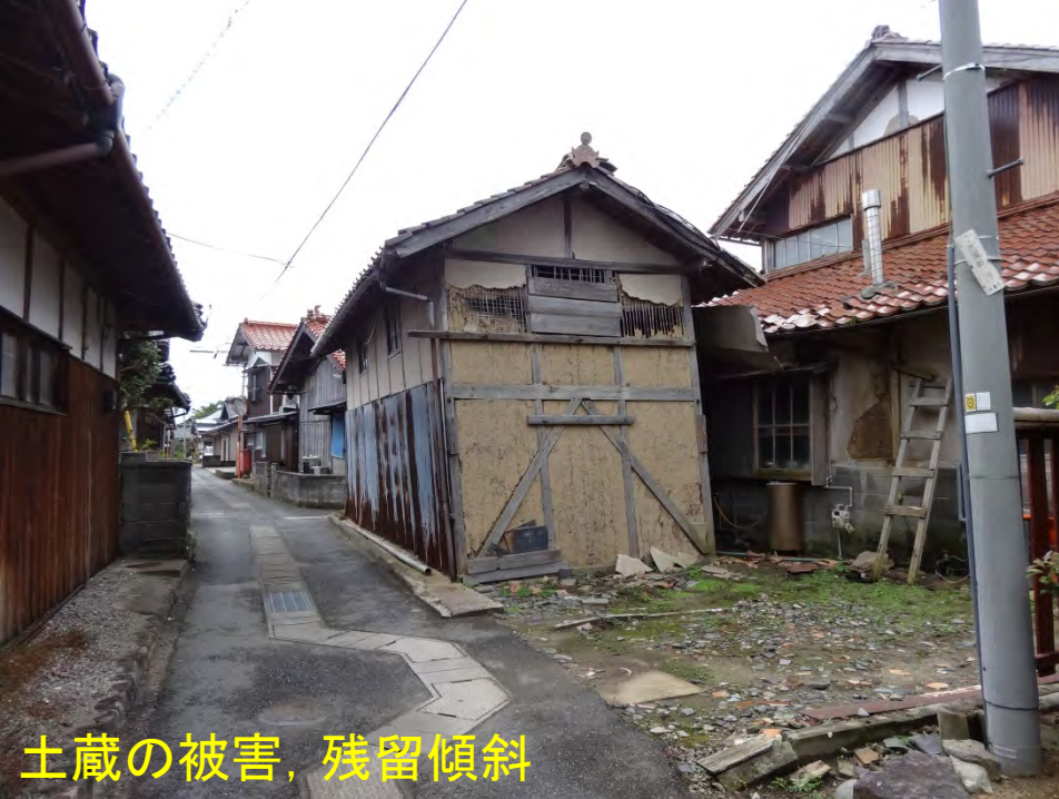
土蔵の被害, 残留傾斜
