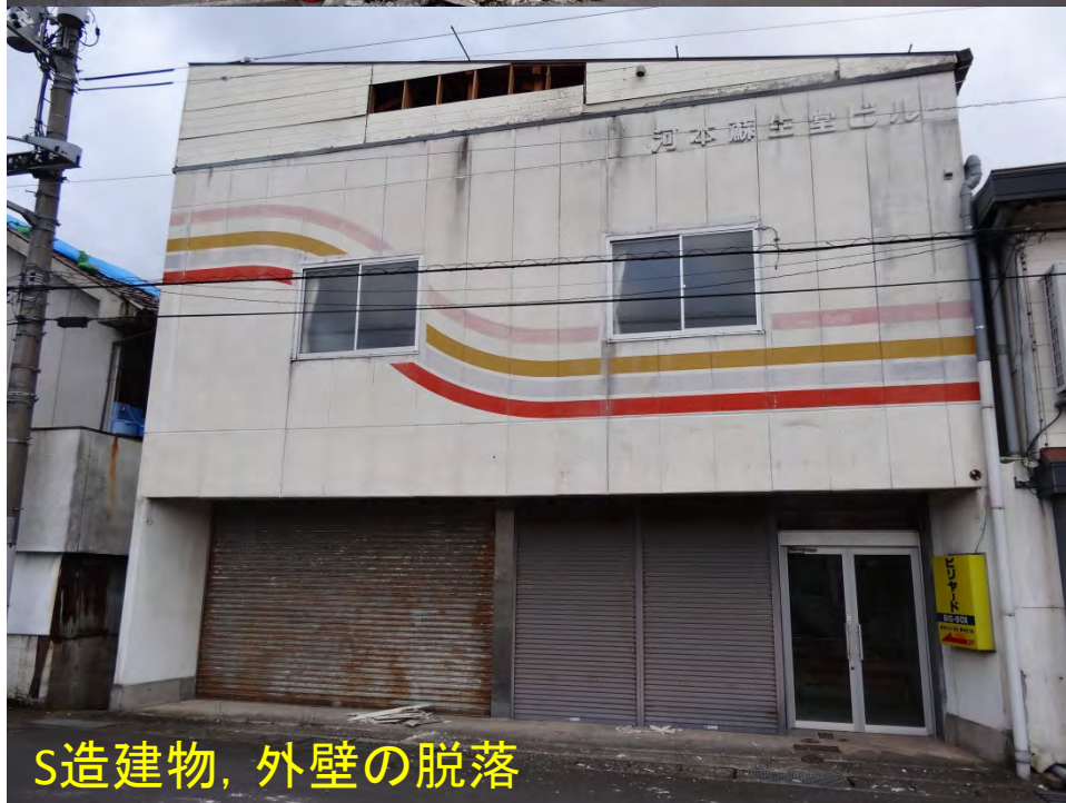
S造建物、外壁の脱落
