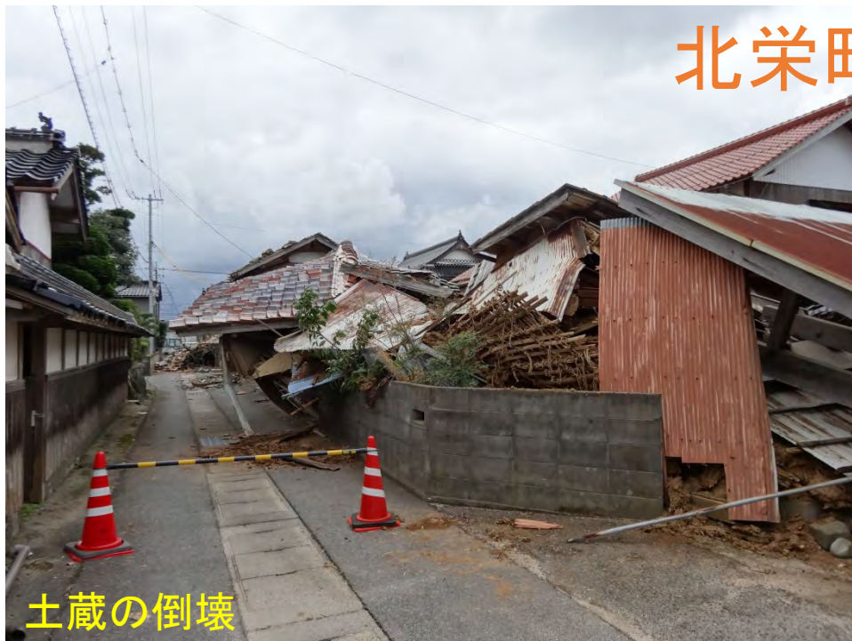
土蔵の倒壊(左と同一)
