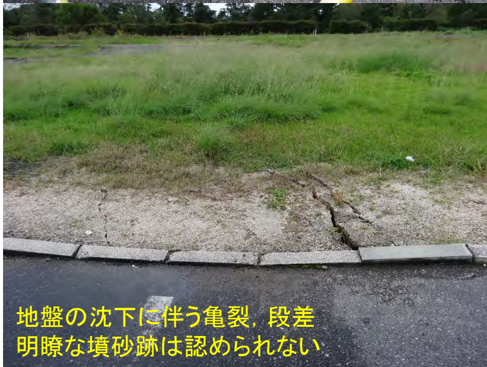
地盤の沈下に伴う亀裂, 段差
