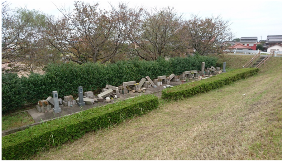
写真 1 1 墓石の転倒（倉吉市天神川左岸）
