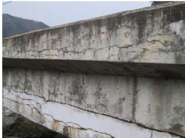
ASRによるコンクリートの劣化
