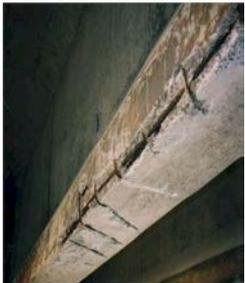
塩害による鉄筋腐食
